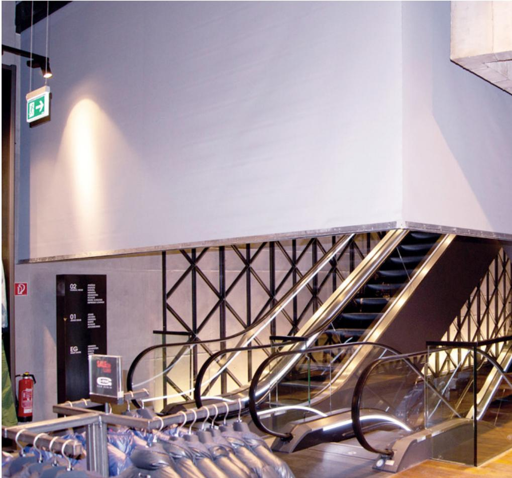
La cortina automática corta humo permite contener el humo y el calor, formando un compartimento a fin de permitir la evacuación de las personas en caso de un incendio.
