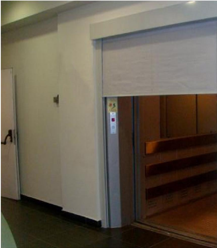
La Cortina Corta Humo SD está diseñada para descender automáticamente y sellar una apertura entre dos áreas para restringir el paso y la propagación del humo y el calor.
