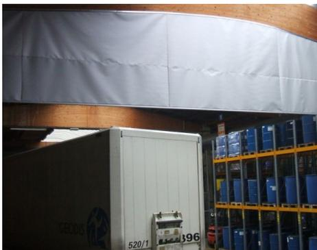
La barrera corta humo también se puede utilizar para cerrar un esquema de cortinas de humo automáticas al posicionarse encima de las mismas y unirse con el perfil de sujeción directamente sobre la caja de una cortina corta humo móvil.
