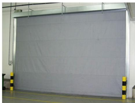
El microprocesador monitorea la posición de reposo cuando se enrolla la cortina y regula la velocidad máxima de cierre a 0,15 m/s.
